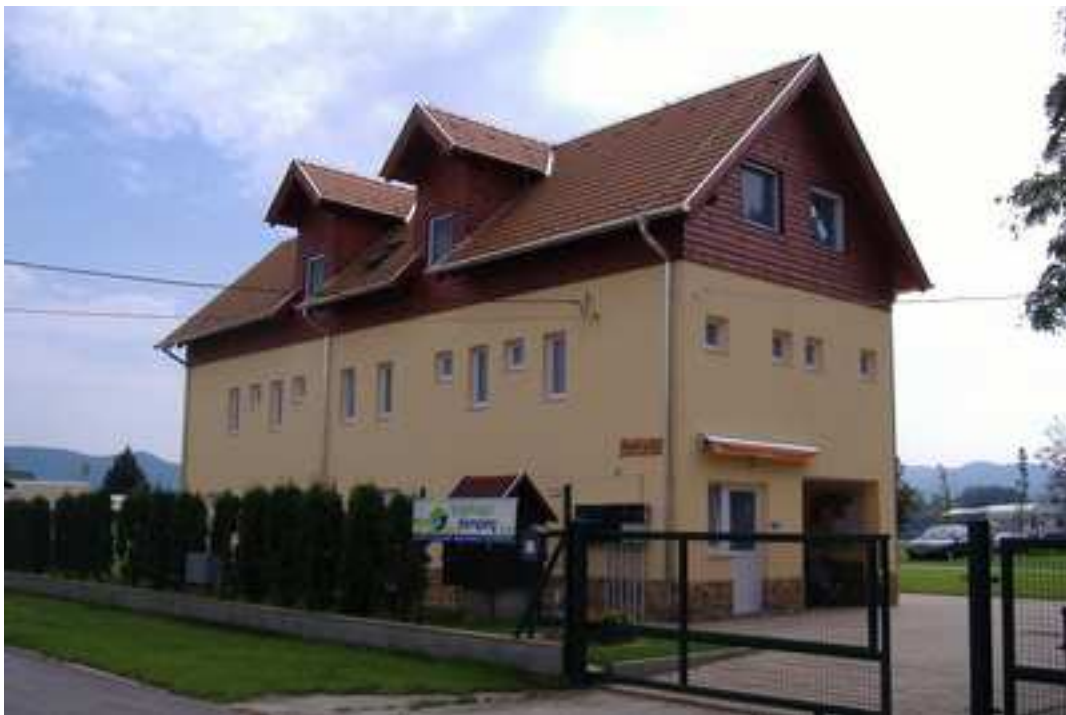
A fogadóépület utcai homlokzata
